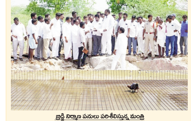
జిడ్డి నిర్మాణ పనుల పరిశీలనకు మంత్రి
